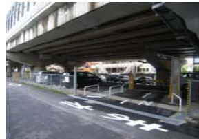
高架下駐車場
